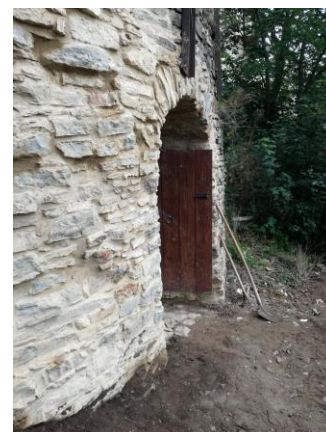
pohled na část jižní strany věže po obnově (září 2017)
