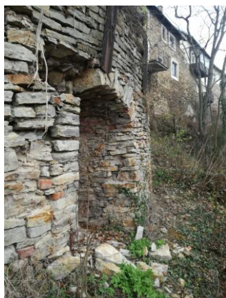
pohled na část jižní strany věže před obnovou (listopad 2016)
