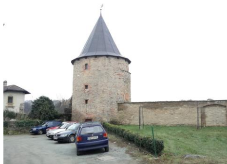
celkový pohled na bývalou vodárenskou věž před obnovou (listopad 2016)
